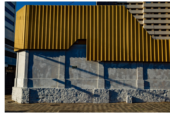
OBRA EM ANDAMENTO
