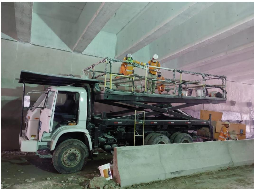
**Aplicação de pintura antichamas na laje e vigas da Trincheira.**
