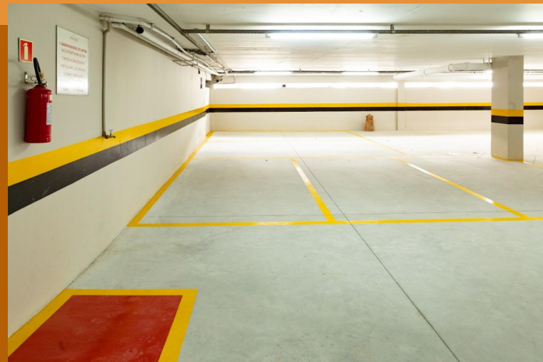
Estacionamento do subsolo do Anexo II recebeu novo piso e sinalização.
