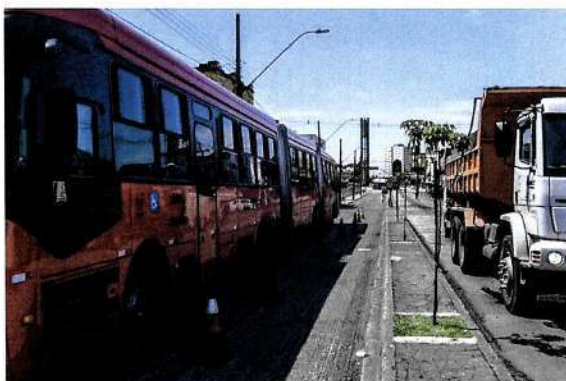
Obras de requalificação das calçadas da Av. República Argentina, da linha Ligeirão Norte-Sul, dez./23. Foto: Pedro Ribas/SMCS
