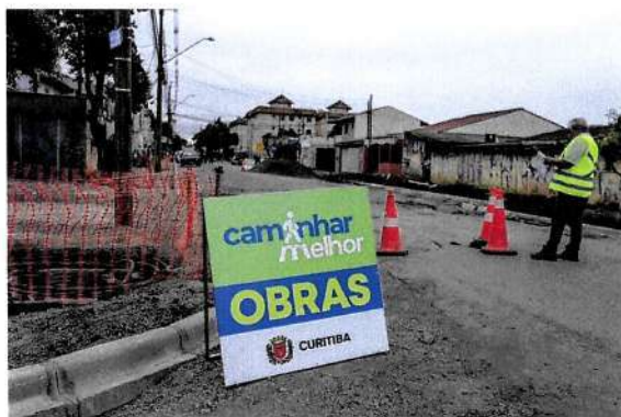
Obras do programa Caminhar Melhor na Rua David Tows no bairro Sítio Cercado, out./23. Foto: Daniel Castellano / SMCS
