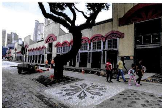
Obras no entorno do Mercado Municipal, out./23. Foto: Daniel Castellano / SMCS
