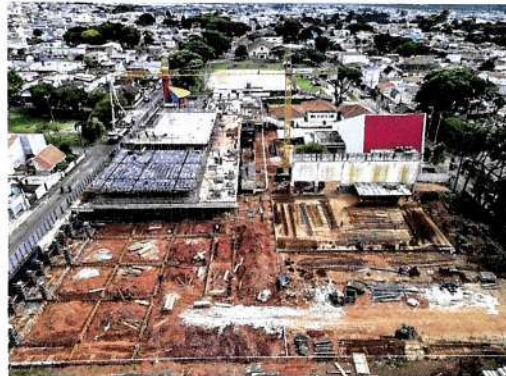
Obras da Rua da Cidadania CIC. Curitiba, dez./23. Foto: Ricardo Marajó/SMCS
