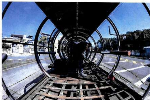
Estações-tubo entram em obras, out./23. Foto: José Fernando Ogura/SMCS, dez./23. Foto: Pedro Ribas/SMCS
