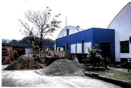
Obra de reforma e ampliação no Centro de Formação e Desenvolvimento Profissional da Guarda Municipal de Curitiba, na CIC. Curitiba, 21/06/2023. Foto: Hully Paiva/SMCS
