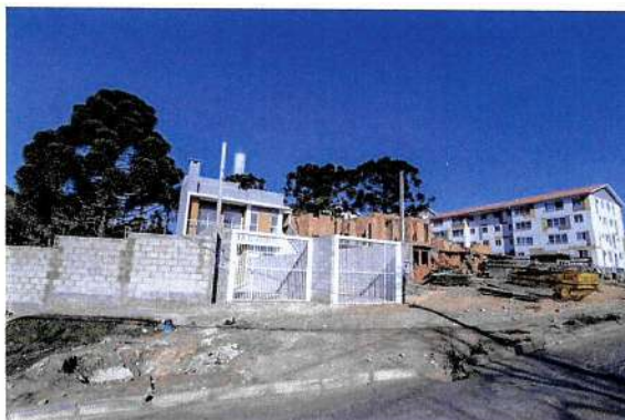
Obras do Residencial Colinas do Norte parceria da iniciativa privada com a COHAB, ago./23. Foto: Daniel Castellano / SMCS
