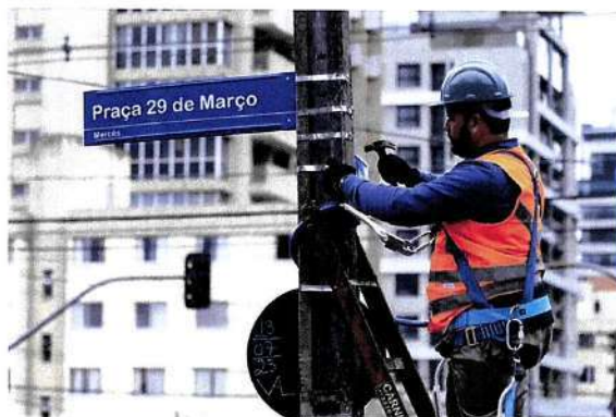
Instalação das novas placas de sinalização refletiva de ruas e logradouros. Curitiba, 17/07/2023. Foto: José Fernando Ogura/SMCS.
