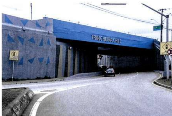
Trincheira do binário das ruas Chile e na Avenida Prefeito Maurício Fruet, ago/2023. Foto: Levy Ferreira/SMCS.
