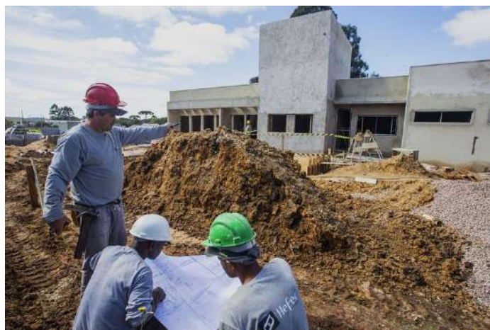
Obras de construção do CMEI Dom Barusso no bairro Ganchinho. Curitiba, 24/08/2022. Foto: Ricardo Marajó/SMCS
