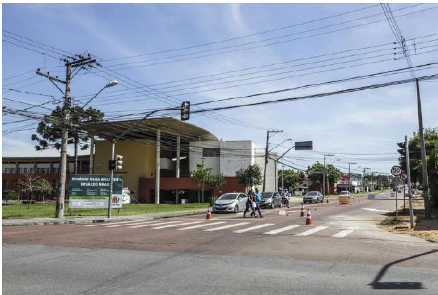
Iniciam as obras do binário Olga Balster e Nivaldo Braga do bairro Caiuru. Curitiba, Foto: Hully Paiva/SMCS
