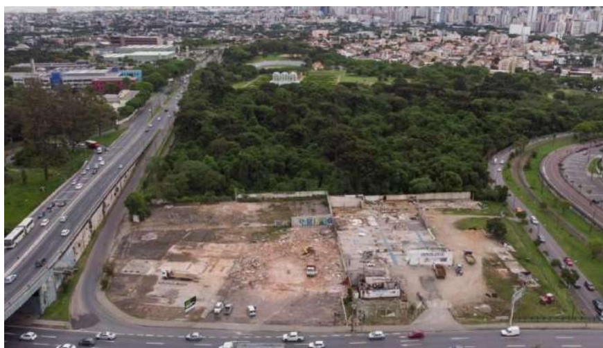
Obra para construção do novo museu. Foto: divulgação / Prefeitura de Curitiba
