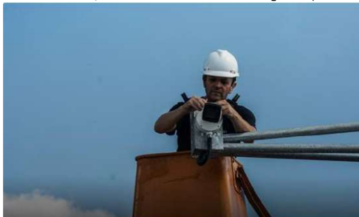
Instalação das três câmeras da Muralha Digital no cruzamento das ruas Eduardo Pinto da Rocha com a João Miqueletto, no Alto Boqueirão. Curitiba, 25/10/2022 Foto: Levy Ferreira/SMCS
