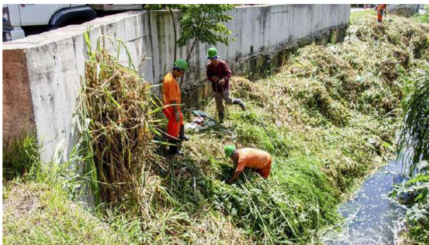
Obras e Limpeza de córrego. Curitiba, 18/03/2022. Foto: Levy Ferreira/SMCS
