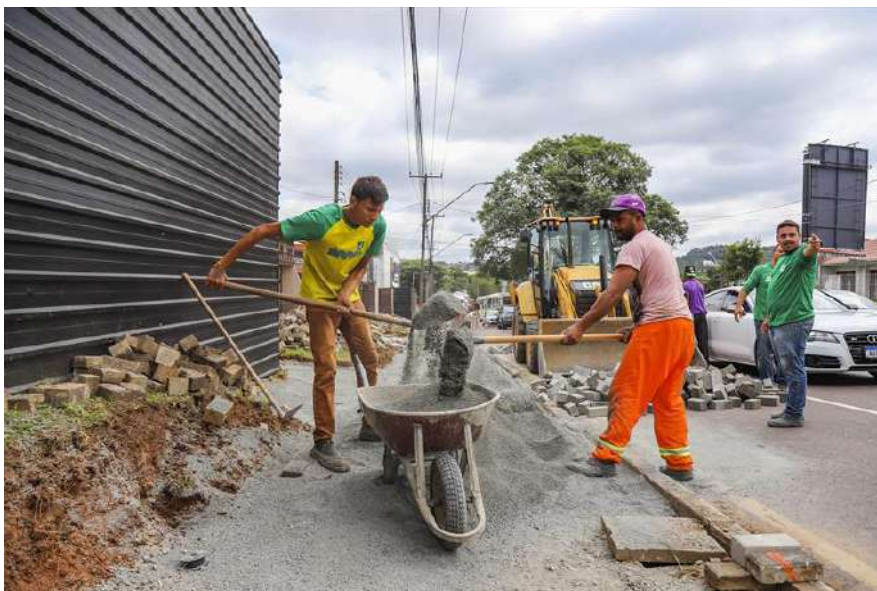
Obras do programa Caminhar Melhor nas ruas da cidade. Curitiba, 06/04/2022 - Foto: Daniel Castellano / SMCS
