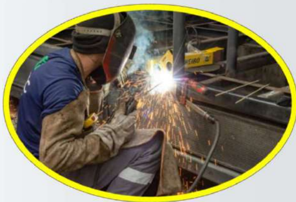
Reforma do Terminal Cabral plataforma centro bairro
